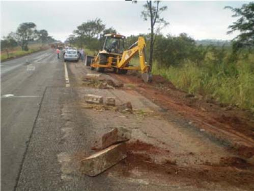
Foto 01 - Contrato UT/19.00462/2009-00: Remoção mecanizada de meio-fio
